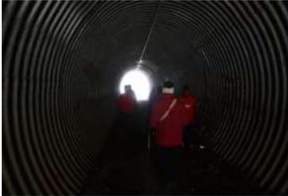
Septembre : le bout du tunnel ?
